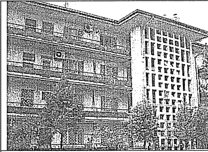
Şekil 11. Petek Apt. 1953, Mimar: Orhan Akverdi, Reşatbey Mahallesi
