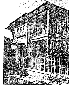
Şekil 10. İhsan Ariel Evi, Mestanzade Mahallesi
