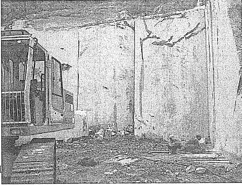
Resim 2. İnkaya Maden ve Petrol Ürünleri San. Tic. Ltd. Şti'ne ait Karakılıç-Karaisalı Yakınlarındaki Mermer Ocağında Bir Üretim Çalışması
