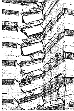
Resim 1. Bina Kolları Birleşiminde Hasar, Kobe, 1995.
