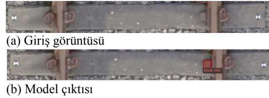
Şekil 10. Eksik bağlantı elemanı hatası model giriş ve çıktı görüntüleri
