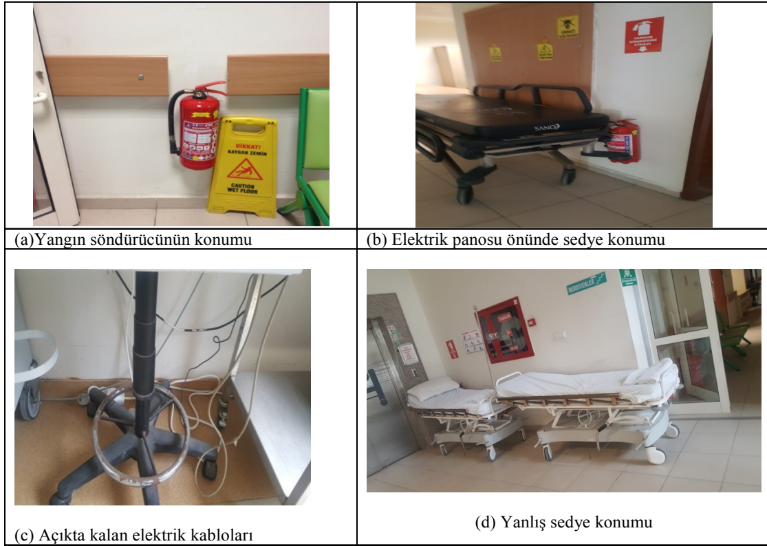
Şekil 1. Tespit edilen tehlike kaynakları ve riskler [6]
