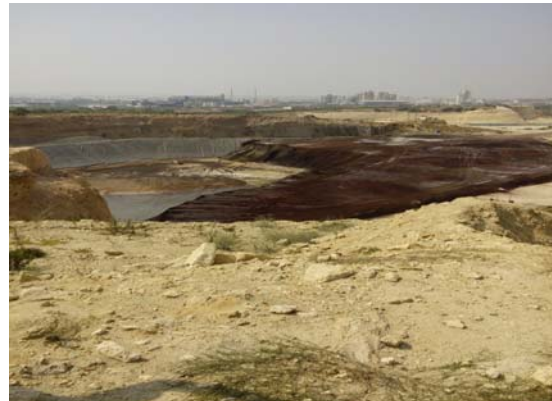
Şekil 1. Çalışma sahasından genel bir görünüm
