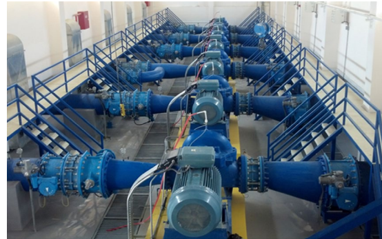
Şekil 8. Mevcut demontaj sistemlerinin hat içerisinde yerleşimi
