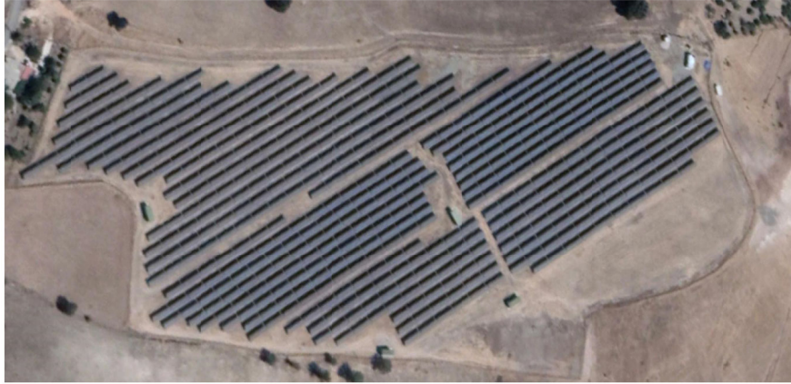
Şekil 4. Güneş enerjisi santrali
