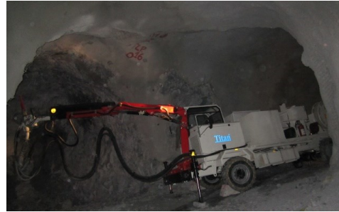
Şekil 10. İşletmede beton püskürtme makinesi çalışırken görünümü
