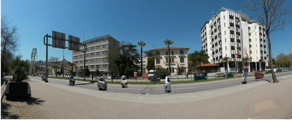
Şekil 5. Vastıfınar Caddesi üzerindeki yapıların oluşturduğu sınır etkisi
