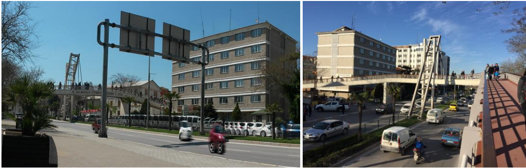
Şekil 6. Mevcut yaya köprüsü
